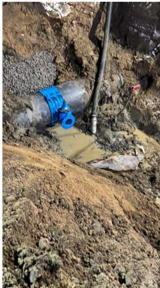
Putkiliitoksen asennus
