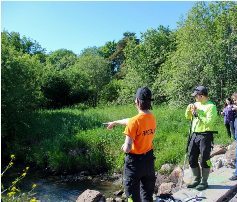
Kuva 18. Suninen(vas.) ja Haaranen ohjeistamassa talkoolaisia soraikon rakentamisessa.
